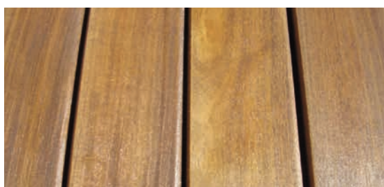
Plancher de terrasse en bois exotique après traitement au CETOL® WF 771
